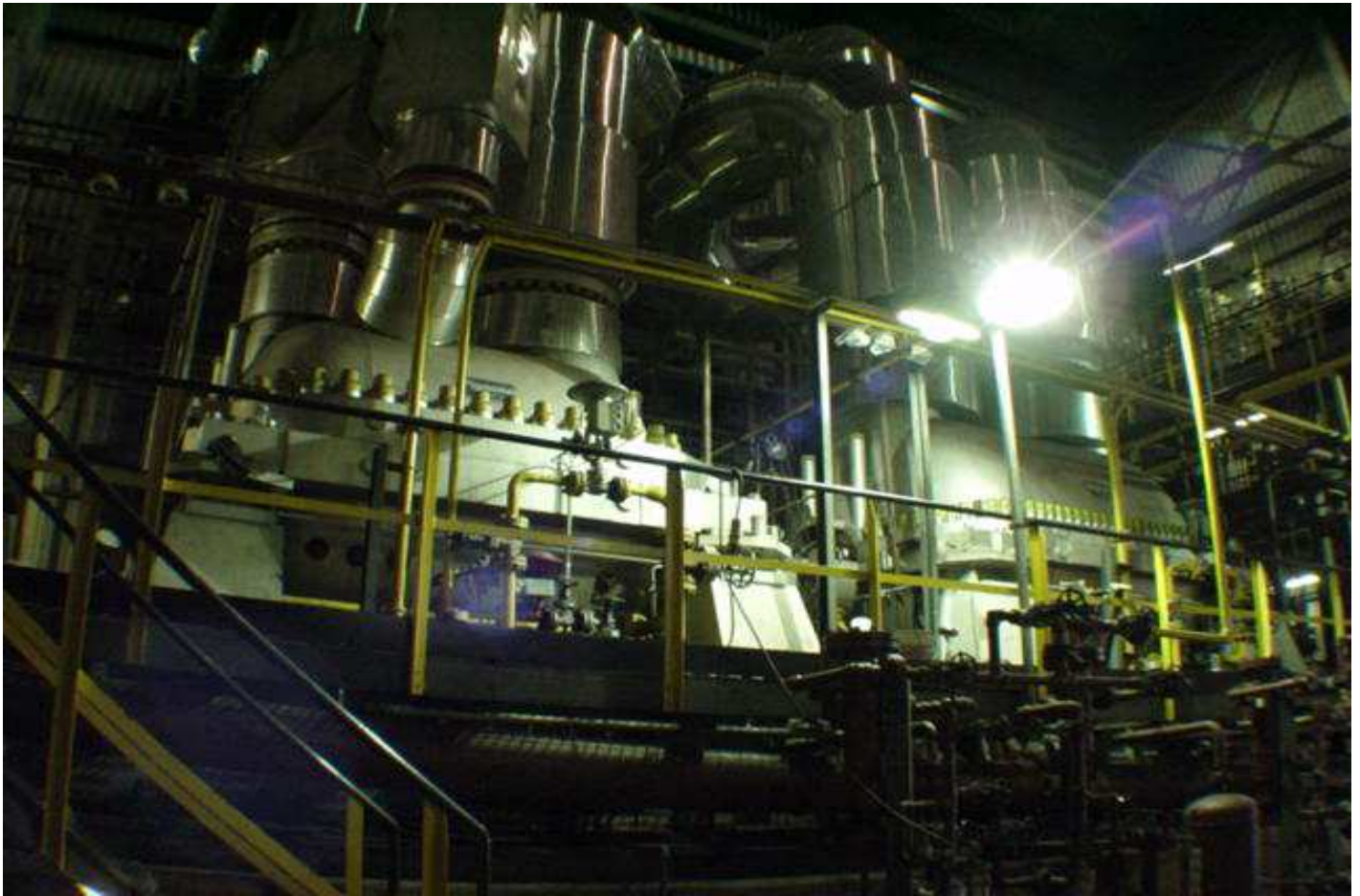
Compressore centrifugo gas siderurgici - CET3
