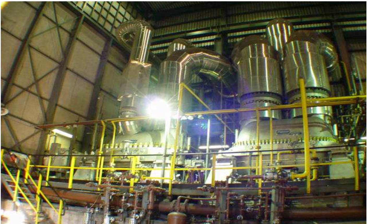
Compressore centrifugo gas siderurgici - CET3
